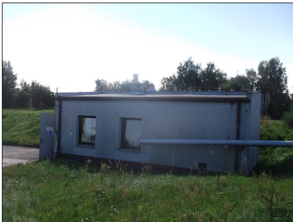
Fot. Widok ogólny budynku
